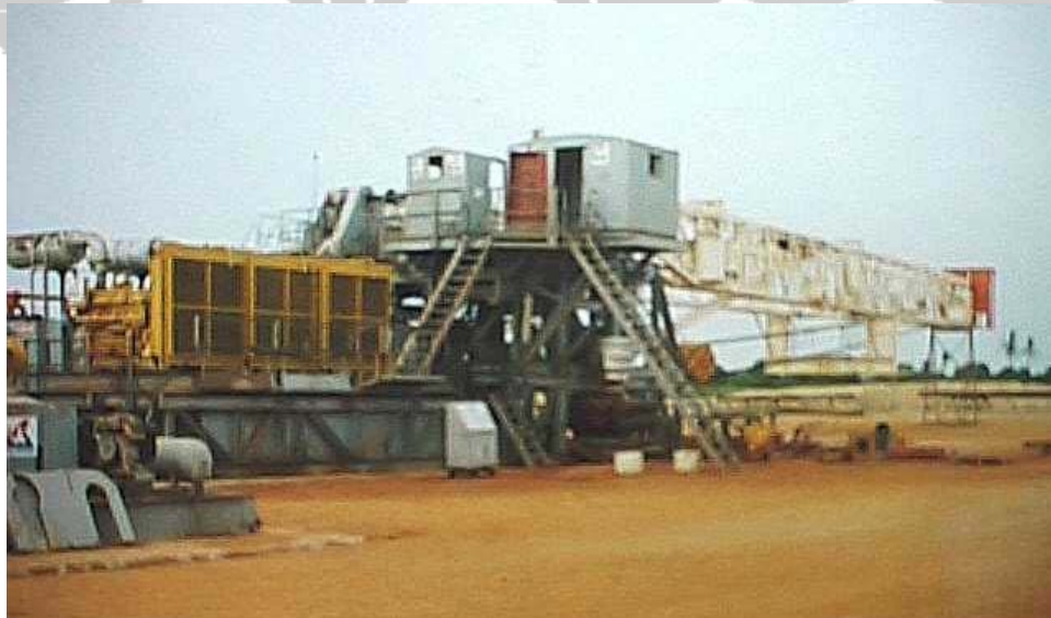
....antes que la torre haya sido levantada
