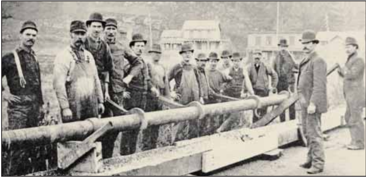
Fig. 12-5. Grupo de trabajadores instalando (1890) un sistema de transporte de crudo.
