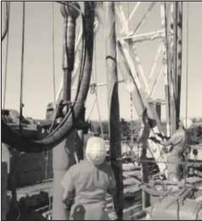
Fig. 3-17. Las labores de perforación han servido de aula y de laboratorio para adquirir experiencias y perfeccionar los equipos para estas tareas.
