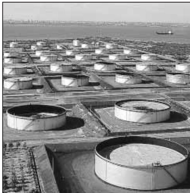
Fig. 4-40. Disposición de tanques en un patio de almacenaje, de donde diariamente se despachan grandes volúmenes de crudo a puertos y/o refinerías.
