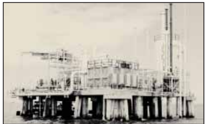
Fig. 5-1. Ejemplo de instalaciones lacustres para manejar gas natural asociado, producido de yacimientos en el lago de Maracaibo.
