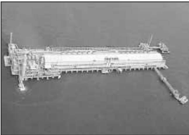
Fig. 4-41. Para aprovechar y manejar grandes volúmenes de gas en el lago de Maracaibo se utilizan plantas gigantes como ésta, cuya capacidad es de unos 10 millones de metros cúbicos por día.
