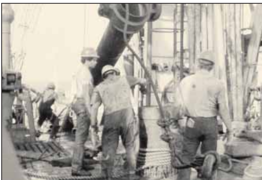
Fig. 3-29. Faenas de manipulación e inserción de un revestidor en el hoyo.
