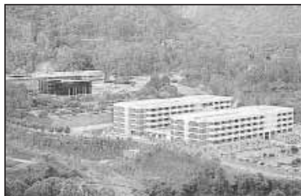
Fig. 11-1. Vista panorámica de las extensas instalaciones de Intevep.
