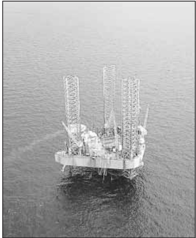
Fig. 4-19. Tipo de plataforma para pozo costafuera.
