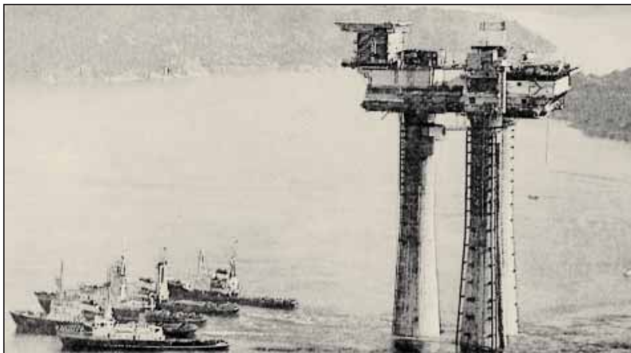
Fig. 10-6. Plataforma de producción, remolcada hacia las aguas profundas del campo Brent, mar del Norte.
