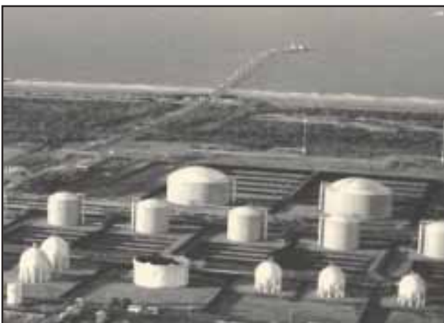
Fig. 8-21. Instalación de almacenamiento de líquidos del gas natural en Jose, estado Anzoátegui.
