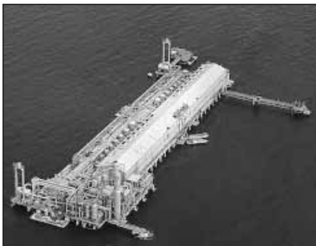
Fig. 8-16. En ciertos sitios en el trayecto terrestre o marítimo se dispone de instalaciones para comprimir y/o tratar el gas natural e impulsarlo hacia los centros de consumo o inyectarlo en los yacimientos.
