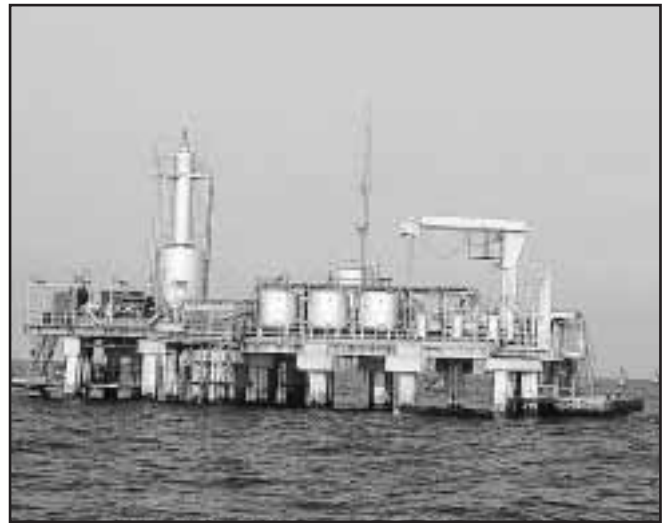
Fig. 4-42. Para mantener y estimular la producción de petróleo de los yacimientos se recurre a la inyección de agua mediante plantas de diseño específico.
