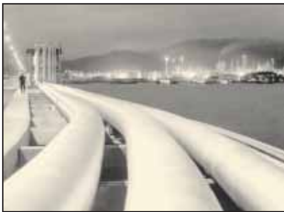
Fig. 8-8. Los ductos transportan diariamente grandes volúmenes de hidrocarburos, crudos y/o derivados, a las terminales para despacharlos luego al mercado nacional o hacia el exterior.
