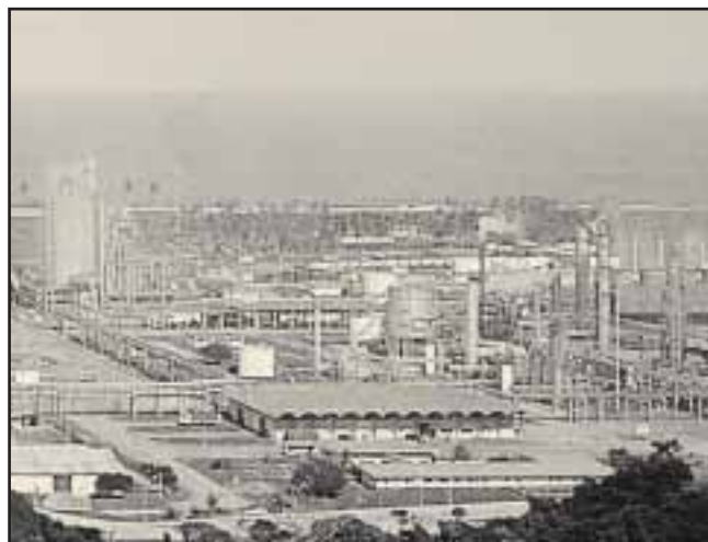
Fig. 7-9. Vista parcial del complejo petroquímico Morón.
