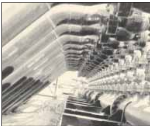
Fig. 4-38. El múltiple de producción facilita el manejo del caudal de cada pozo en la estación de flujo y separación. El número de este tipo de instalación depende de la cantidad de pozos y de la extensión de cada campo.
