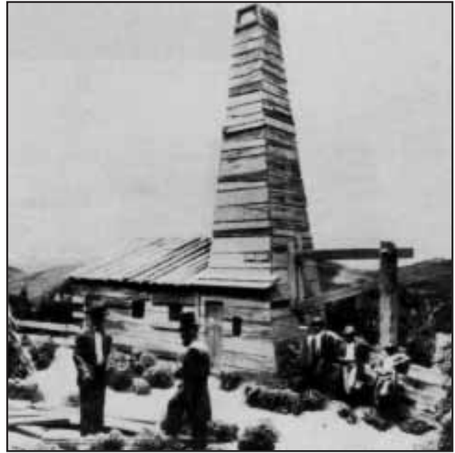
Fig. 2-2. Reproducción del primer pozo que dio inicio a la industria petrolera en Titusville, Pennsylvania, el 28 de agosto de 1859, perforado por Edwin L. Drake.
