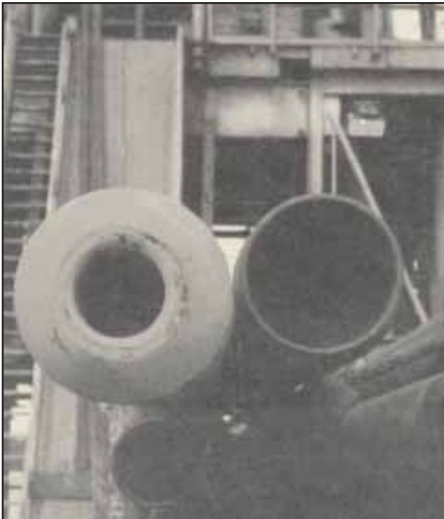
Fig. 3-32. Zapata instalada al primer tubo de revestimiento que va al hoyo.
