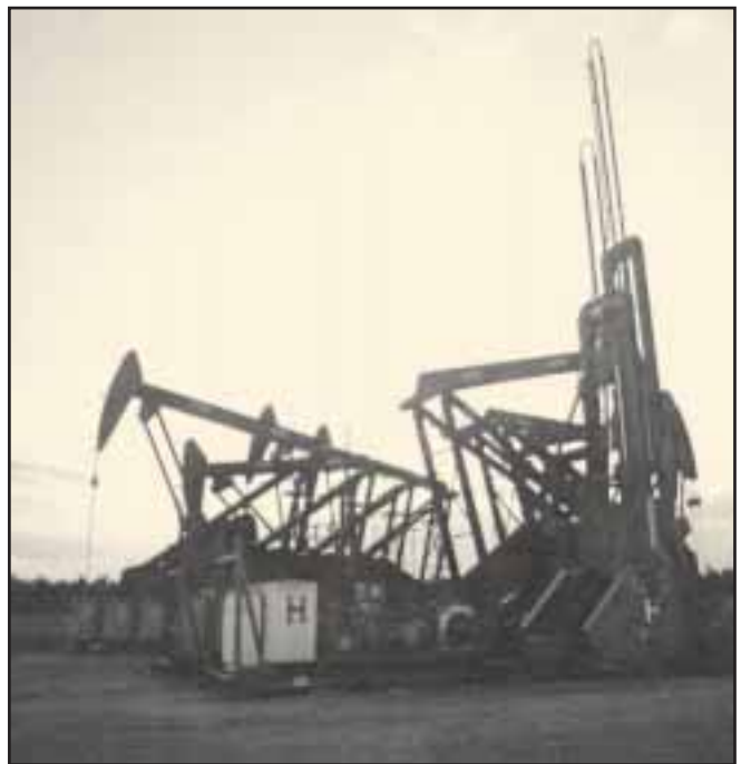
Fig. 4-59. Vista de una concentración o macolla de pozos, perforados desde un solo sitio, en Cerro Negro, Faja del Orinoco, estado Monagas.
