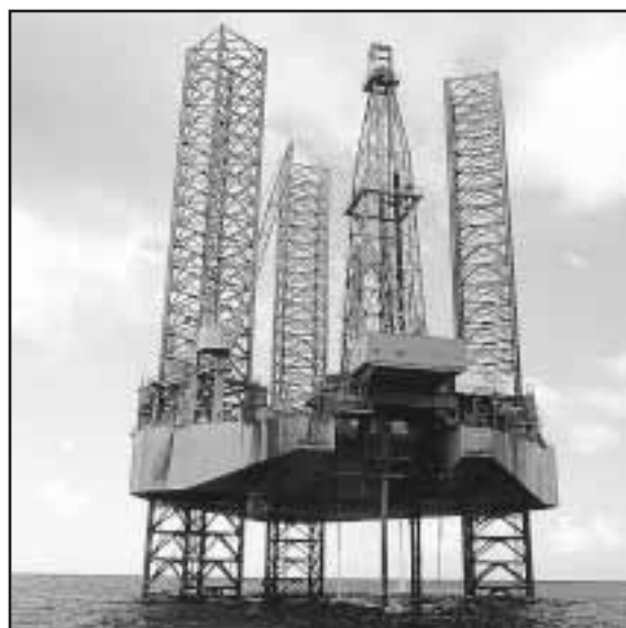
Fig. 5-25. La exploración costafuera ha logrado descubrir grandes yacimientos de petróleo y de gas libre. Esta clase de plataforma integral de perforación se ha utilizado en muchos sitios del mundo.
