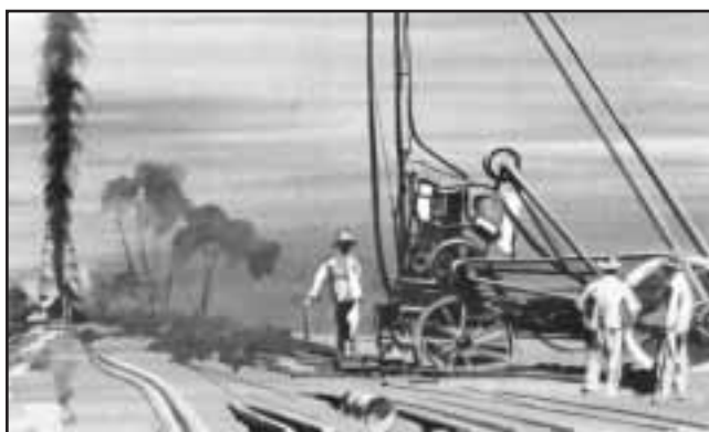
Fig. 2-23. El riesgo de un reventón estuvo siempre presente cuando se abrían pozos utilizando el método de perforación a percusión. Con las innovaciones de equipos, fluido de perforación y control del hoyo inherentes al método de perforación rotatoria, el riesgo ha sido casi eliminado.
